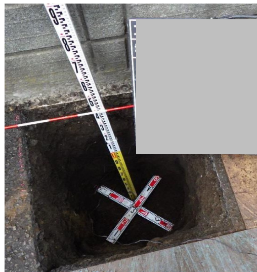
鋼管ポール設置工事の様子
