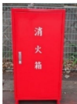
初期消火箱（固定式）
