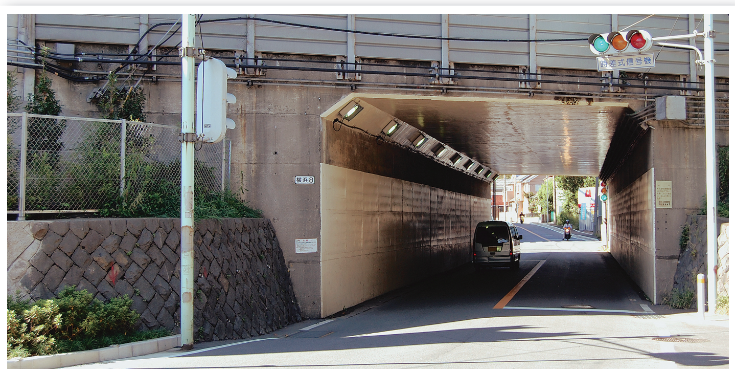
工事前は歩道と車道が一体
