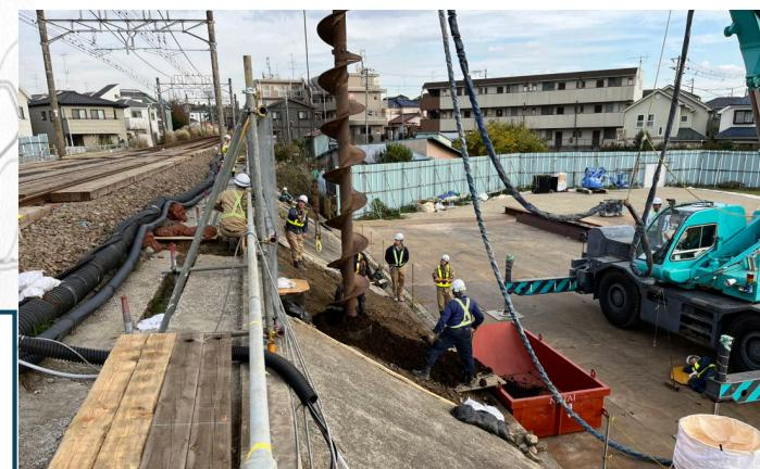
⑥瀬谷地内線【相鉄線 土留め杭打設】
