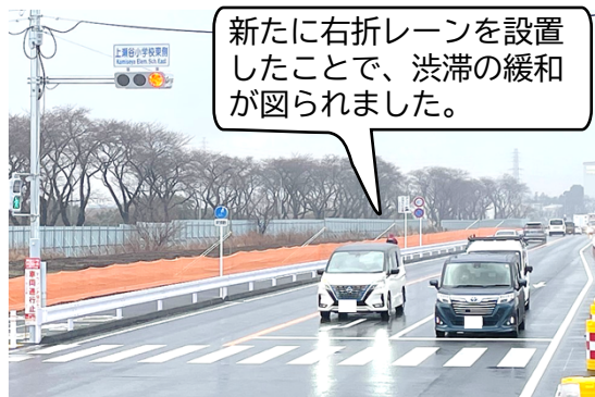
切り替え後のバイパス道路【1】の上瀬谷小学校東側交差点
