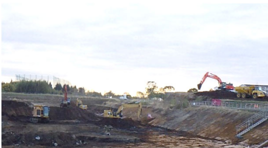
相沢川調整池（地下式）工事状況
