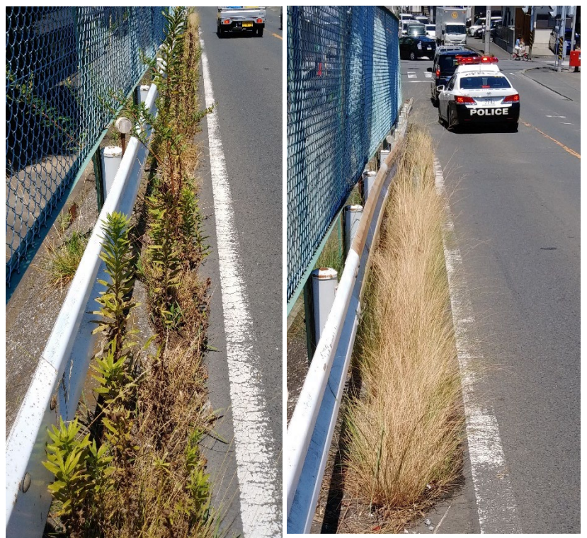
作業後(2週間後)の状況
