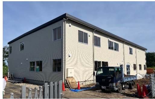
事務所外観（7月2日時点：工事中）
